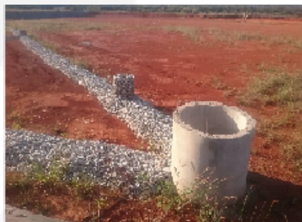
Foto 02. Caixa CIP e drenos DPB e DGP instalados na base da Unidade de Aterragem do Aterro Sanitário de Paracatu.
