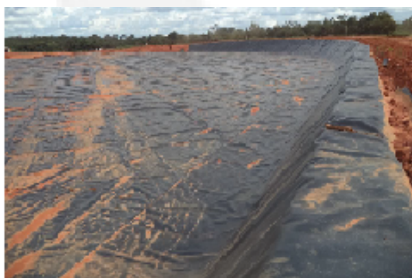
Foto 03. Geomembrana de PEAD da impermeabilização de base e taludes da Unidade de Aterragem do Aterro Sanitário de Paracatu sendo instalada durante as obras da implantação inicial.
