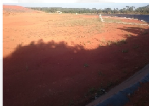
Foto 04. Sistema de impermeabilização de base e taludes da Unidade de Aterragem do Aterro Sanitário de Paracatu já instalado em definitivo.
