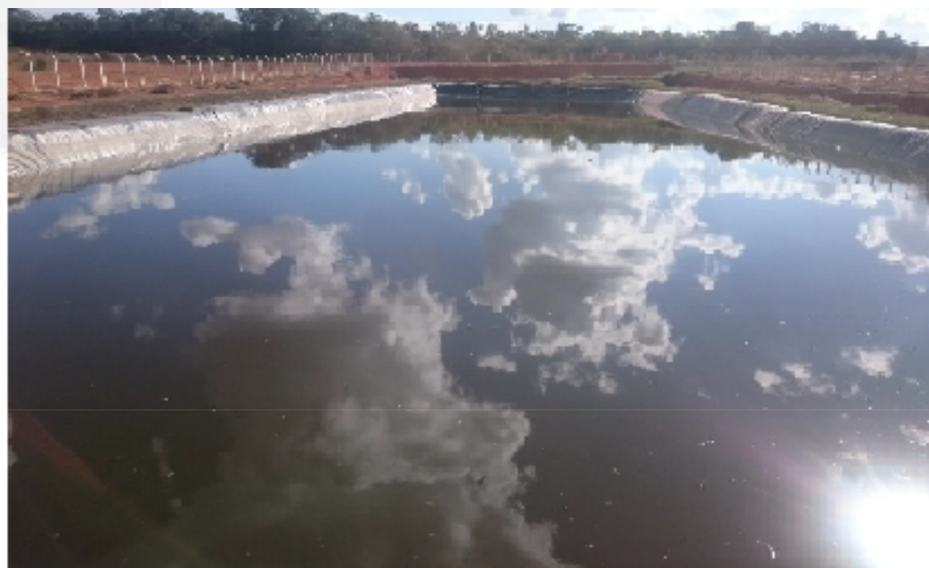
FIGURA 4 – Lagoa facultativa instalada na ETE do Aterro Sanitário de Paracatu.
