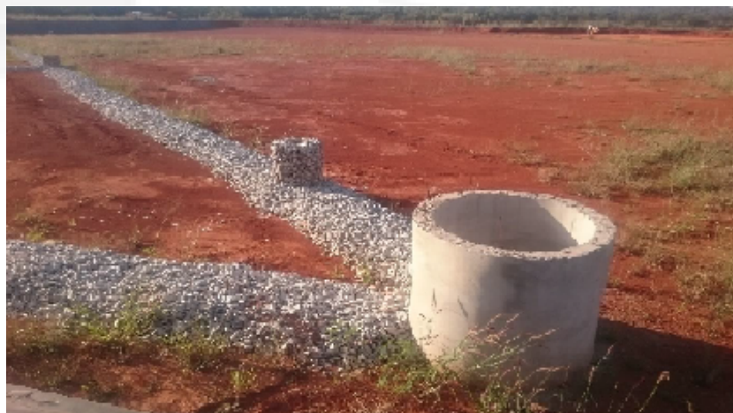
FIGURA 2 – Caixa CIP e drenos DPB e DGP instalados na base da Unidade de Aterragem do Aterro Sanitário de Paracatu
