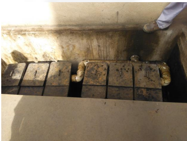
Foto 03 – Sistema separador de água e óleo
