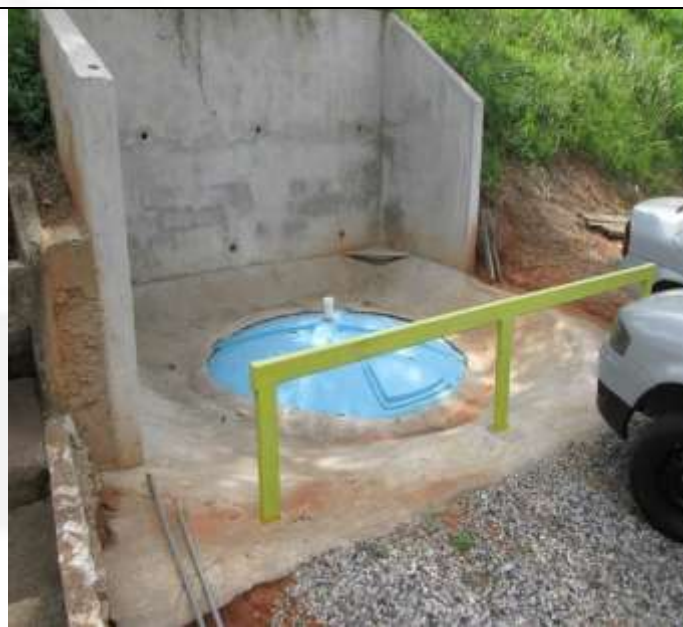
Foto 12: fossa séptica complementar com filtro anaeróbio
