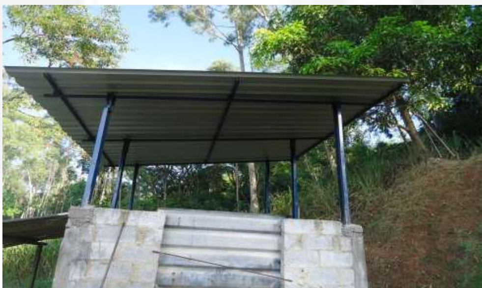
Figura 11: armazenamento de cinzas das caldeiras coberto
