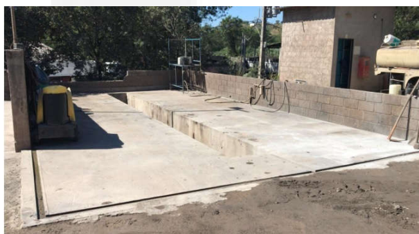
Foto 3: Lava jato impermeabilizado e canaletas
