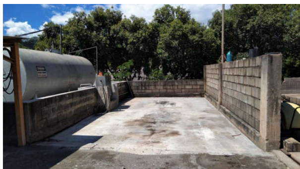
Foto 1: Área de abastecimento impermeabilizada
