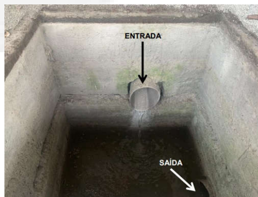
Foto 6: Caixa de passagem (drenagem pluvial)
