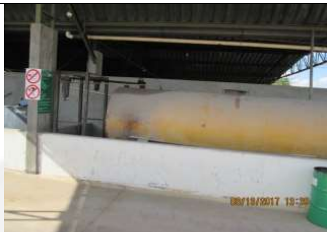
Foto 4: Tanque de armazenamento de combustível de 10 m³ com caixa de contenção de vazamento
