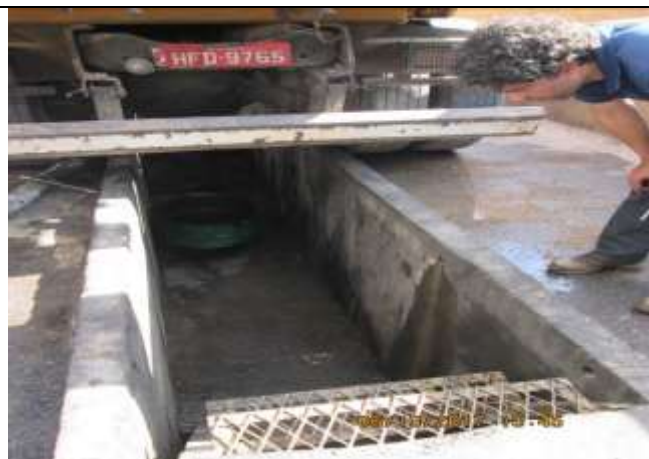
Foto 3: Lavador de veículos com piso impermeabilizado
