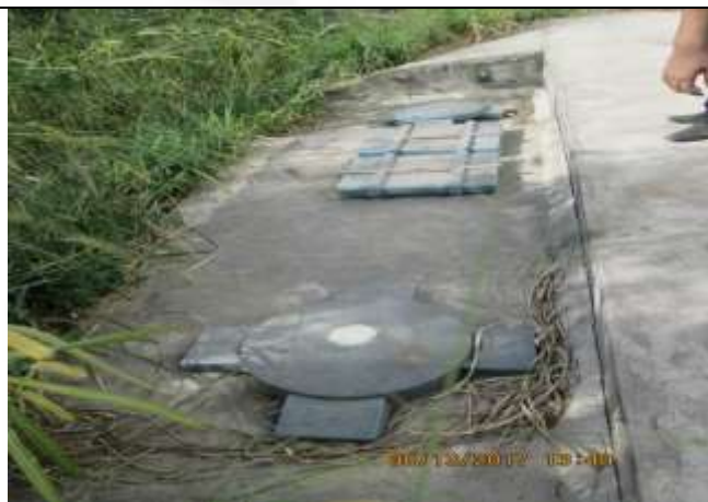
Foto 6: Caixa SAO adjacente a oficina mecânica
