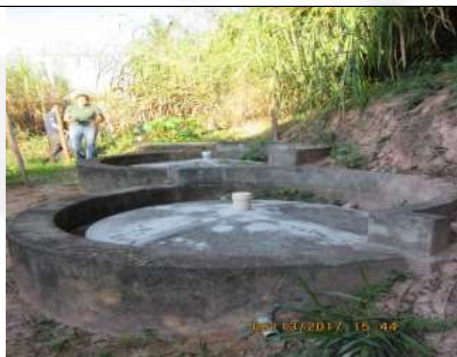
Foto 14: Fossa séptica com sumidouro do empreendimento
