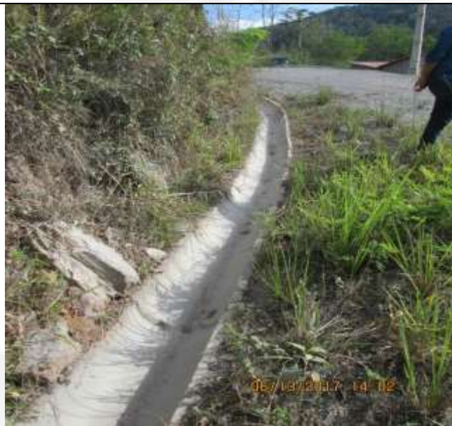
Foto 2: Canaleta de concreto de água pluvial nas vias internas de acesso
