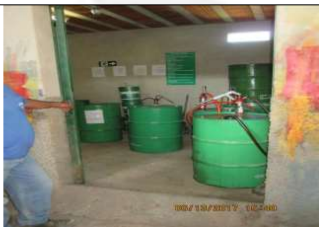
Foto 7: Depósito de óleo e graxa com piso impermeabilizado e barreira de contenção de vazamento
