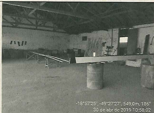
Foto 05: Setor de montagem
