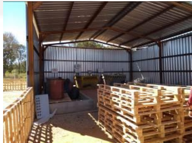
Foto 02. Galpão de Armazenamento de resíduos
