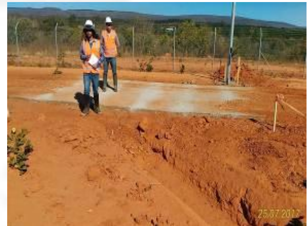
Foto 08. Caixas passagem sistema de drenagem
