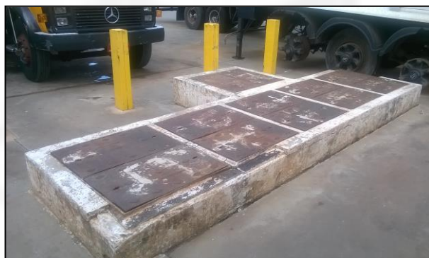
Foto 04. Caixa Separadora de Água e Óleo-SAO.
