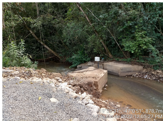
Foto 04. Sistema eletrônico de Monitoramento de Vazão a jusante da barragem B6.
