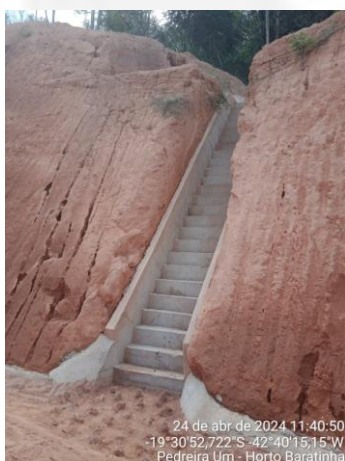
Foto 5: Escada (sistema de drenagem).
