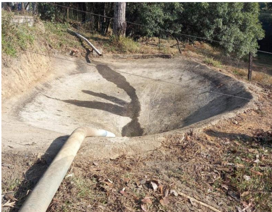
Imagem 1: Lagoa de decantação. Fonte: SLA.
