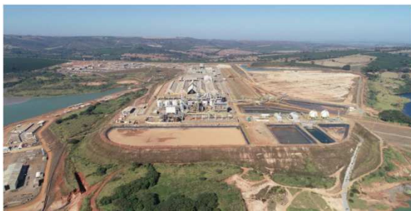
Foto 01. Andamento das obras de implantação da Planta Química
