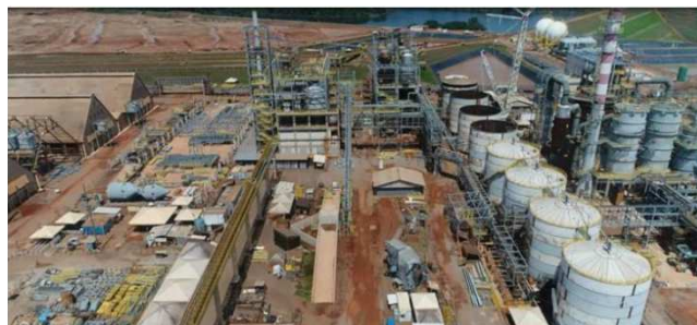
Foto 02. Andamento das obras de implantação da Planta Química
