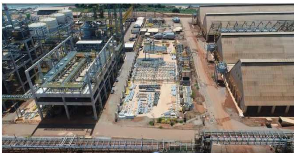
Foto 03. Andamento das obras de implantação da Planta Química
