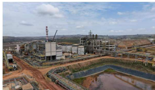
Foto 04. Andamento das obras de implantação da Planta Química
