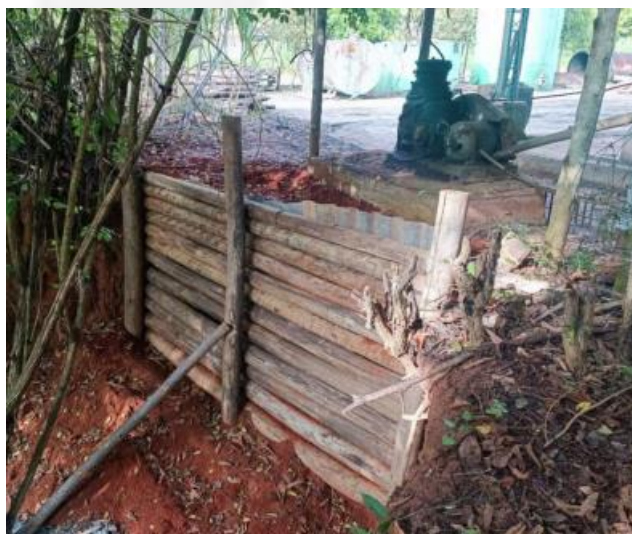
Foto 11: Contenção realizada no processo de erosão.
