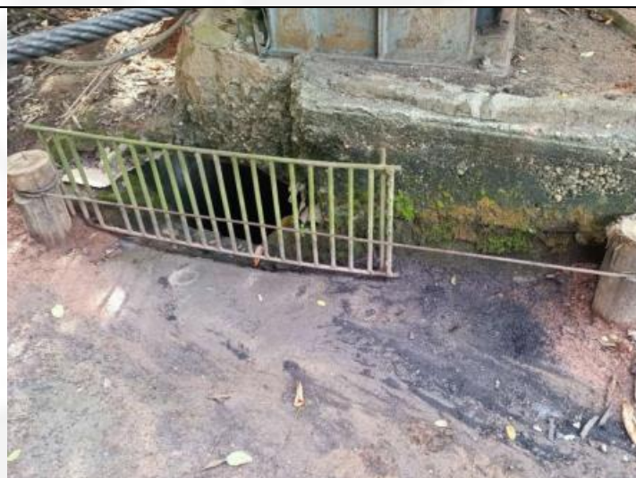
Foto 12: Caixa receptora de águas pluviais.
