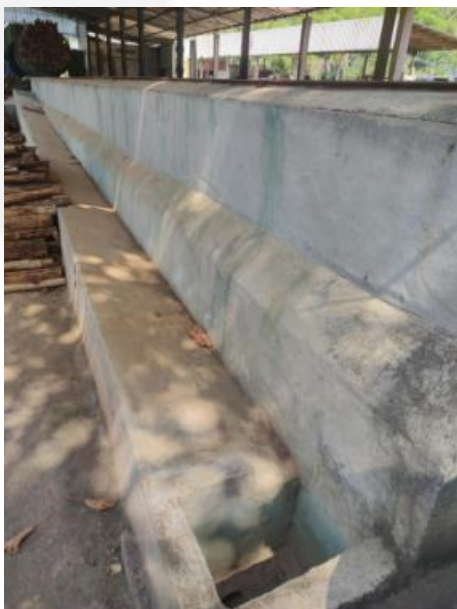
Foto 3: Sistema de drenagem interna do galpão da UTM.
