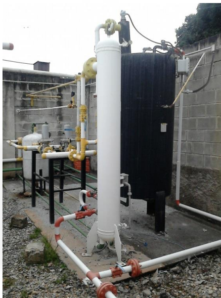
Figura 5 – Vaporização de GLP
