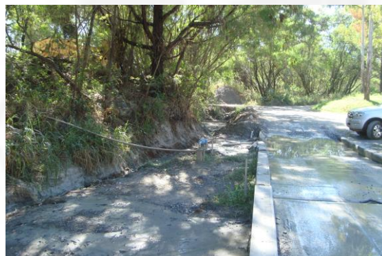
Foto 10. Bacia de contenção de finos do sistema de drenagem.
