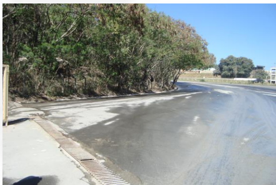
Foto 09. Canaleta de drenagem pluvial na entrada do empreendimento e pátio externo asfaltado.
