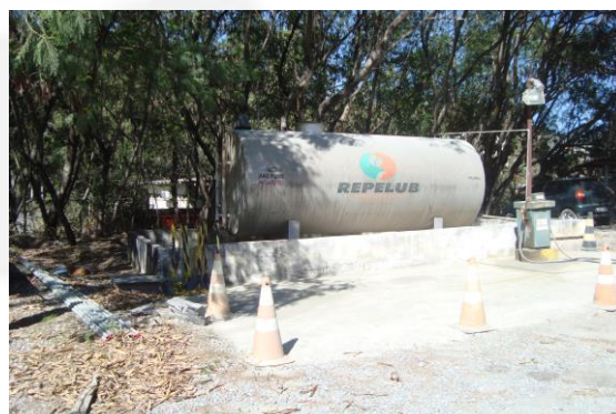
Foto 12. Tanque de abastecimento aéreo com CSAO.
