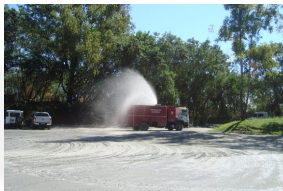
Foto 08. Umectação das vias por meio de caminhão-pipa.
