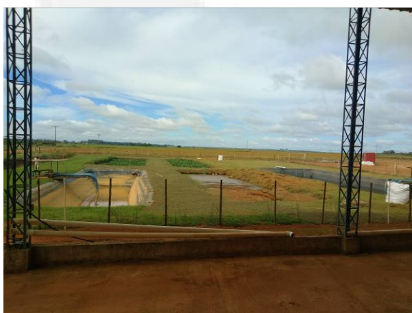
Lagoa de retenção de água residuária da lavagem de batata e cebola
