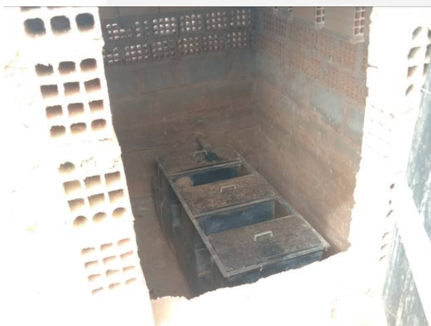
Caixa separadora de água e óleo
