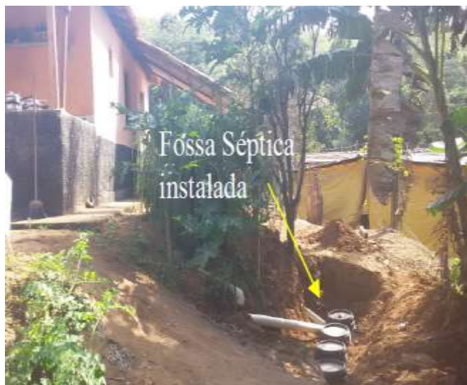
Figura 3: fossa séptica instalada
