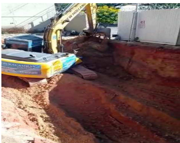
Foto 05. Obra em andamento para instalação do sistema de tratamento de efluentes líquidos.
