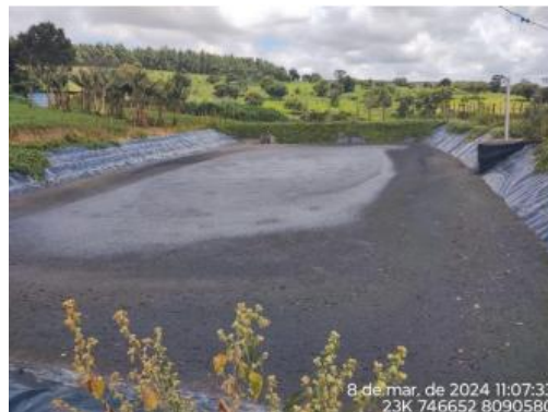
Figura 7. Lagoa de estabiliza o.
