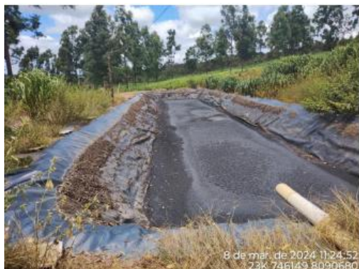
Figura 6. Lagoa de estabiliza o.
