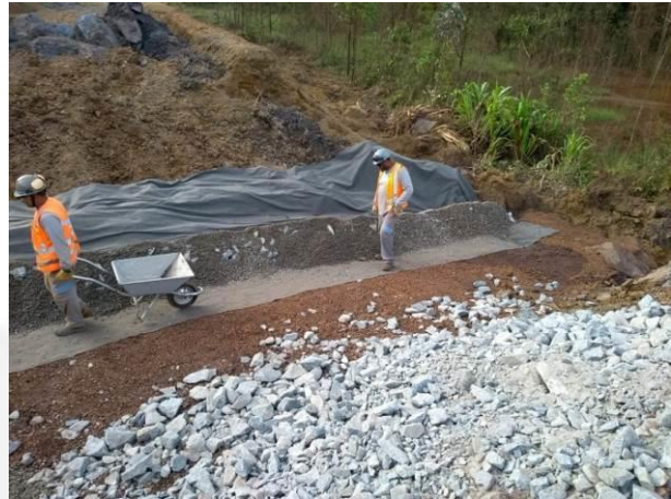
Figura 4: ampliação do dreno de fundo
