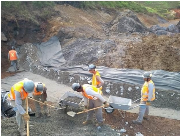
Figura 5: Dreno de fundo da pilha
