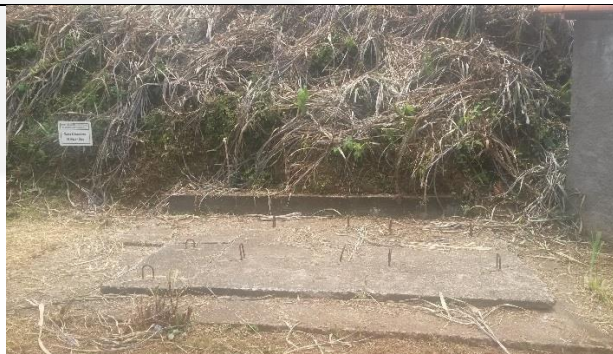
Foto 06: Caixa separadora de água e óleo
