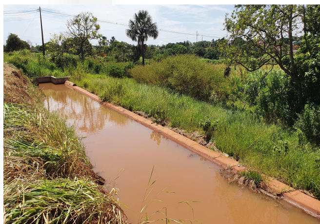
Figura 2: Dissipador e caixa de retenção - vertedouro.
