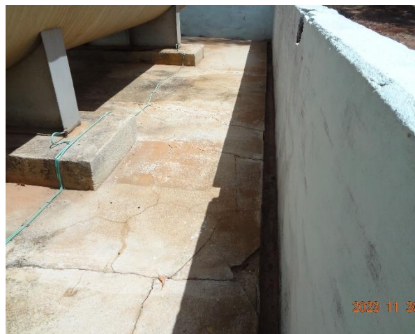
Foto 18 – Detalhe do piso na bacia de contenção apresentando algumas trincas na camada superficial do piso.
