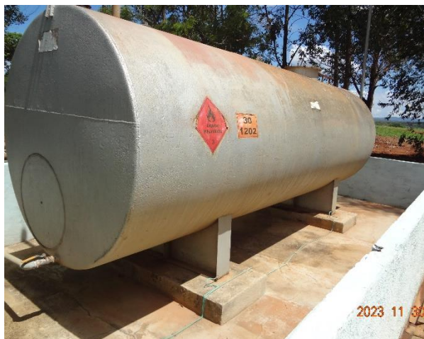
Foto 17 – Tanque de armazenamento de combustível.
