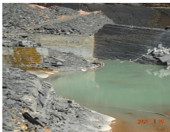
Foto 04 – Água represada no fundo da cava. Detalhe: ao fundo uma bomba utilizada para abastecer caminhões pipas.
