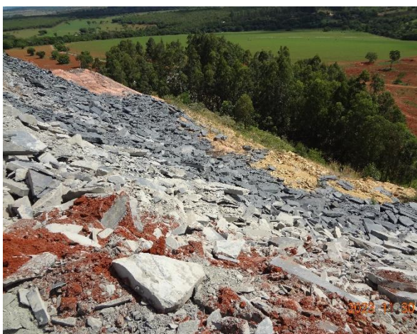
Foto 06– Berma estreita e descontínua com talude instável, na pilha de estéril da Minerar.
