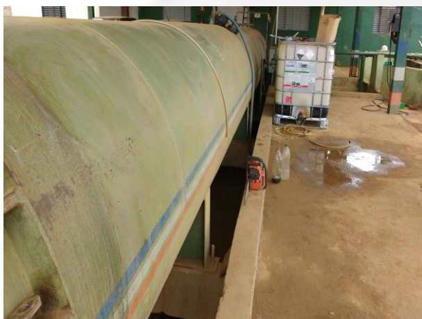
Foto 01. Autoclave e fosso de contenção
