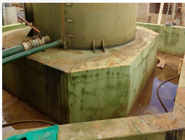
Foto 02. Bacia de contenção do tanque de solução
