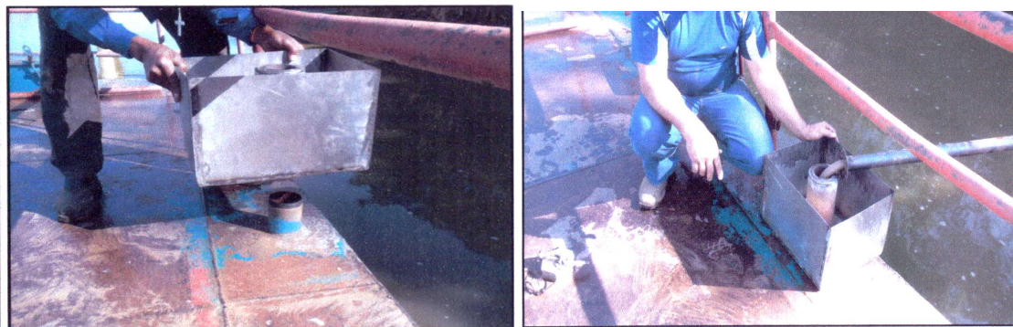
Figura 10 - Sistema de contenção contra vazamentos no abastecimento da draga.
