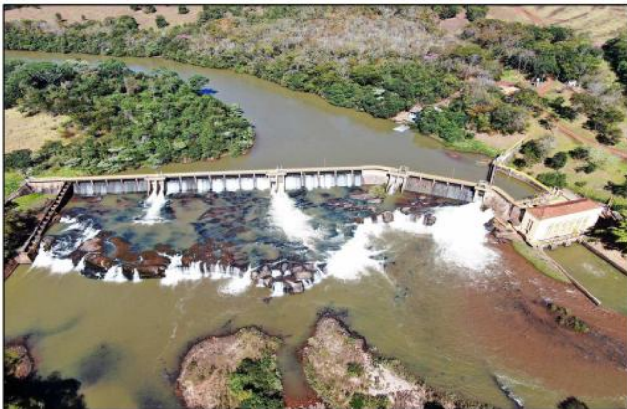
Figura 03: Vista aérea do reservatório e barramento, vertedouros de crista livre e descargas de fundo (2020). Fonte: Ofício IC - documento SEI nº 53173753 (2022).
