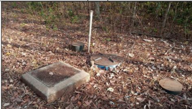
Foto 04: Sistema biodigestor e sumidouro - Casa de Força Fonte: Ofício IC - documento SEI nº 53173753 (2022)
