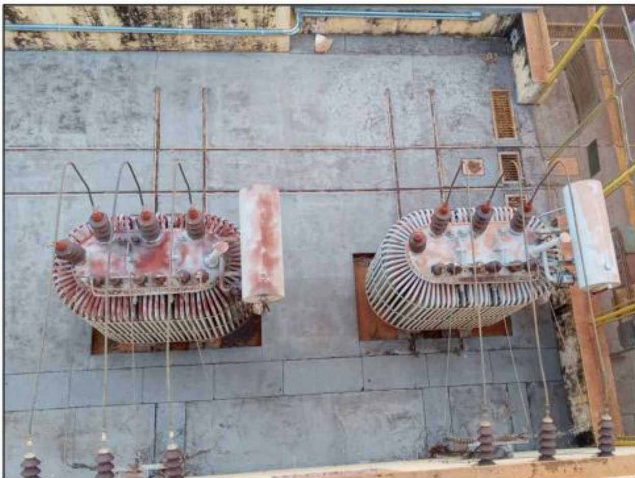
Figura 06: Transformador Elevador.
