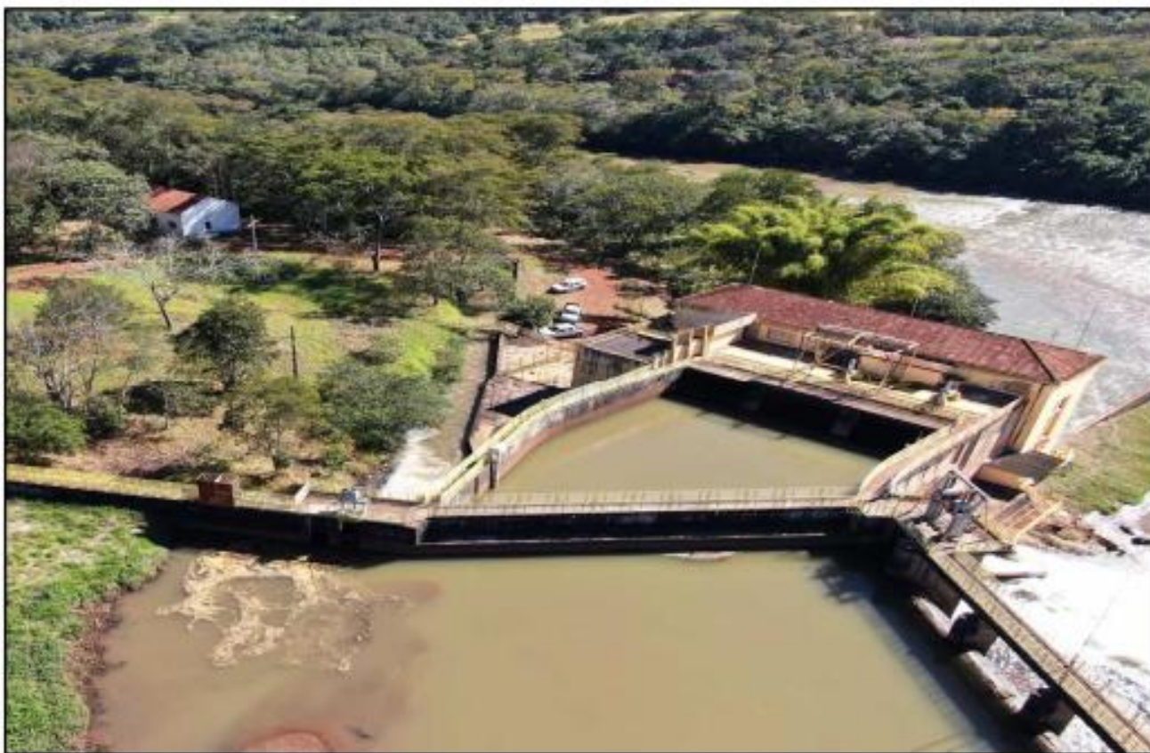
Figura 04: Câmara de carga/canal de adução (2020). Fonte: Ofício IC - documento SEI nº 53173753 (2022).
