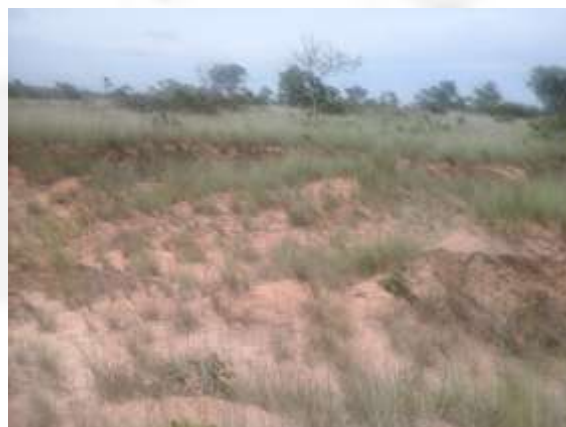
Foto 28: Erosão em recuperação.
