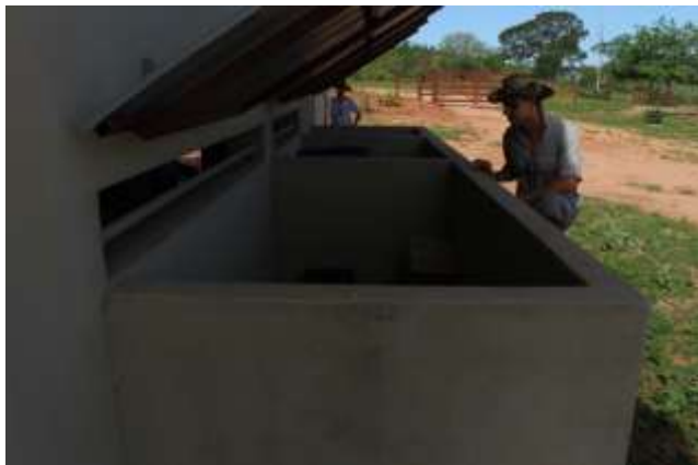
Foto 05: Local de disposição de resíduos com contenção e impermeabilizada. (Fazenda São Joaquim)
