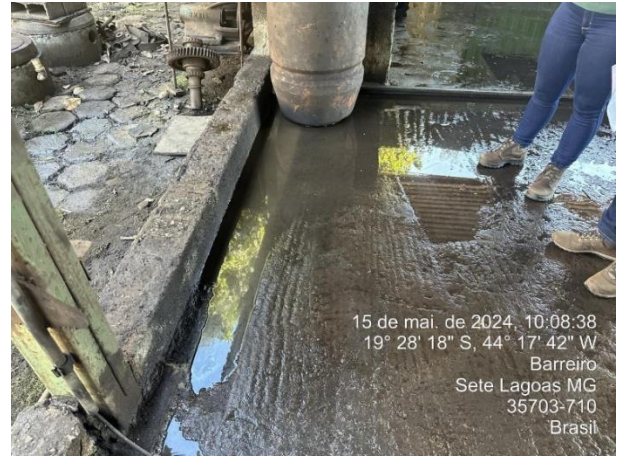
Foto 26: Acúmulo de efluente na canaleta da oficina, com indicação de possível obstrução, visto que a CSAO que recebe esse efluente encontrava-se seca.
