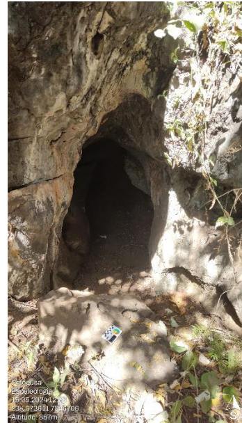
Foto 86: Vista externa da ACAV-03 (reentrância).
