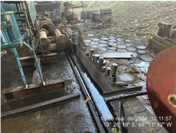
Foto 27: Materiais dentro da canaleta da oficina mecânica, obstruindo a passagem do efluente de drenagem.
