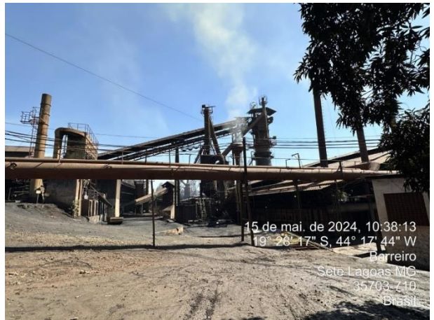
Foto 54: Vista geral de parte do complexo industrial.
