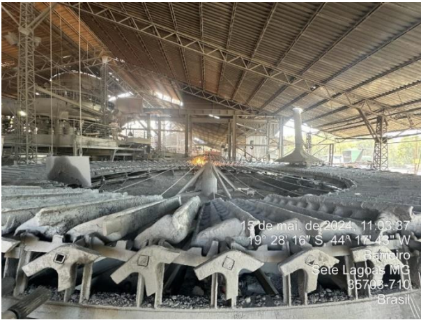
Foto 61: Área do rodeio, com estruturas em boas condições de conservação.
