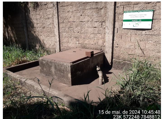
Foto 36: Caixa de alvenaria lacrada do Poço artesiano 01, localizado fora da área operacional da empresa.
