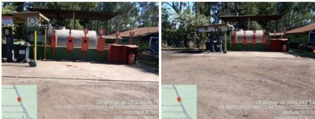
Figura 3. Execução da obra de melhorias conforme solicitação do ITEM 10
