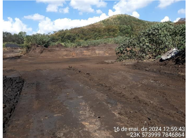
Foto 2: Pátio de depósito de pó de balão em atividade.
