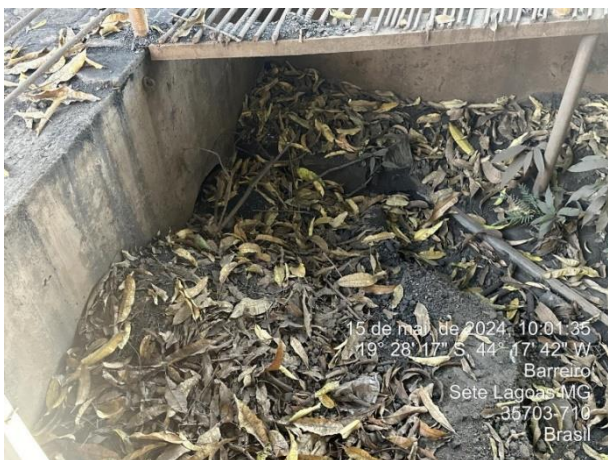
Foto 9: Canaleta de drenagem que compõe sistema para efluentes pluviais com significativa quantidade de sedimento e matéria orgânica.
