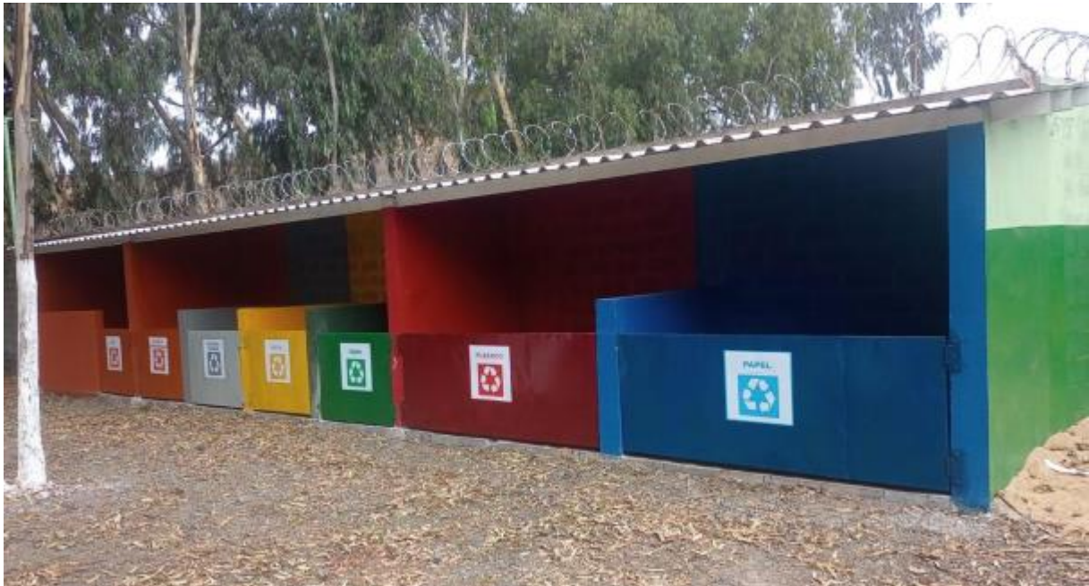
Figura 40. Baias de Resíduos na Siderúrgica Setegusa Ltda
