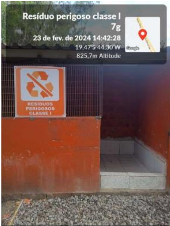
Figura 41. Baia destinada a armazenamento de resíduo Perigosos Classe I
