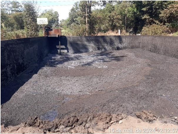
Foto 19: Tanque de alvenaria localizado na parte alta da área operacional que recebe lama de pó de balão.
