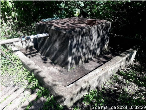
Foto 39: Caixa de alvenaria lacrada do Poço artesiano 02, localizado fora da área operacional da empresa.
