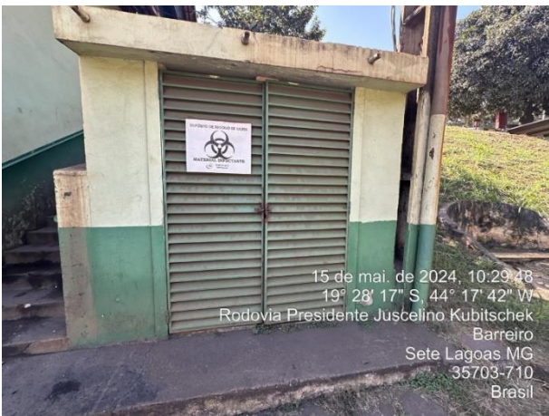
Foto 47: área de acondicionamento de RSS
