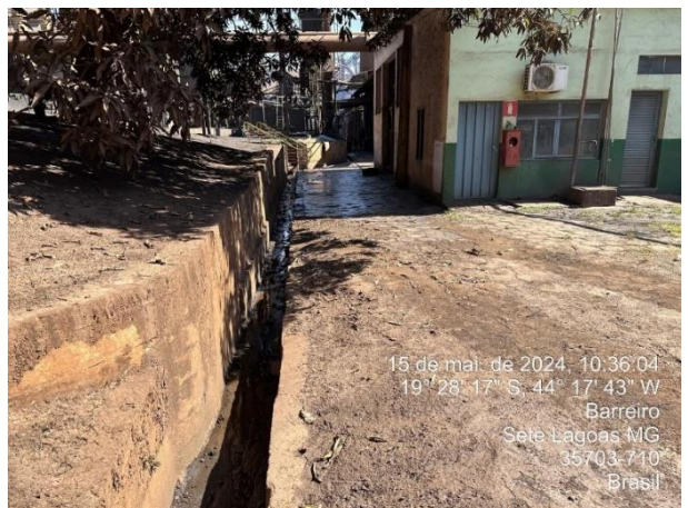
Foto 58: Canaleta de drenagem da área próximo ao alto-forno.
