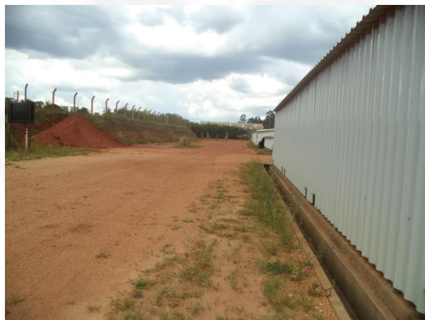
Foto 08. Sistema de drenagem em torno da célula de resíduo classe I
