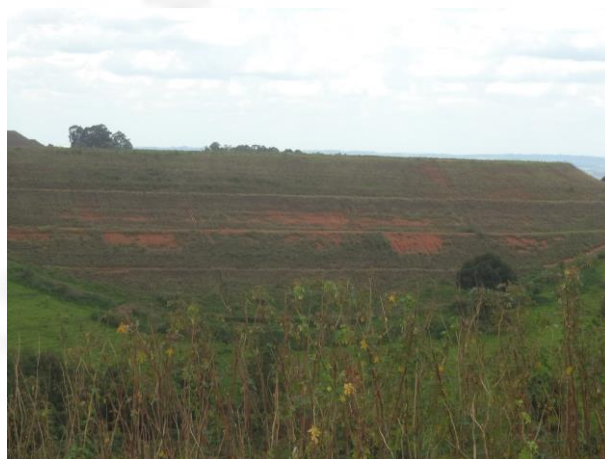
Foto 02. Talude pilha de estéril
