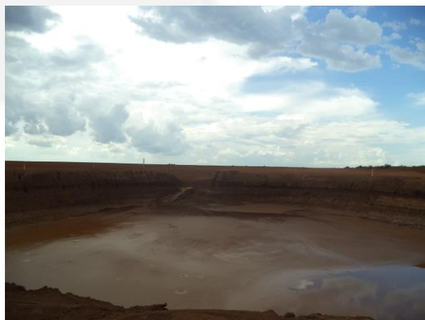
Foto 09. Pilha de estéril II com bacia de contenção águas pluviais
