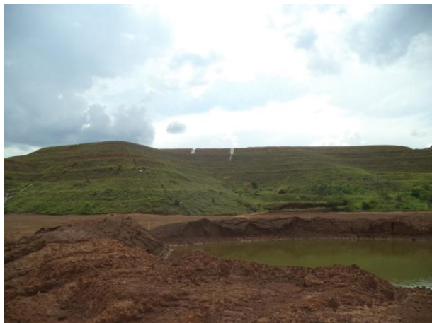
Foto 05. Pilha com bacia de contenção a jusante
