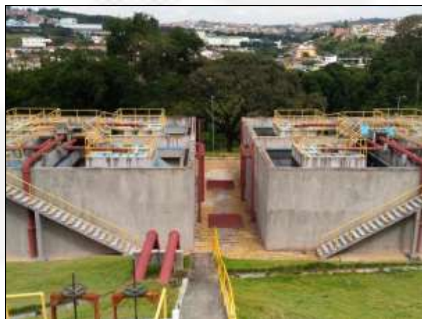
FOTO 04 – Reatores UASB
