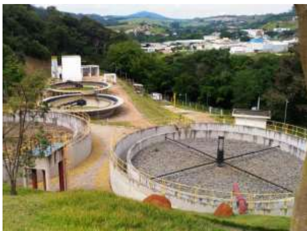
FOTO 05 – Filtros biológicos seguidos de decantadores secundários
