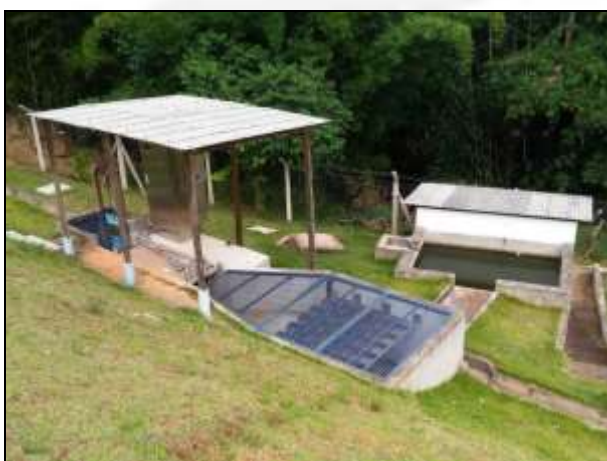
FOTO 07 – Desinfecção por raios ultravioletas
