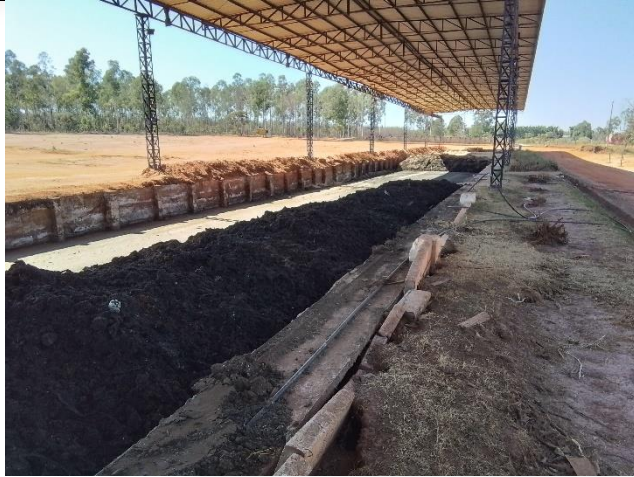
Foto 09: Galpão de compostagem
