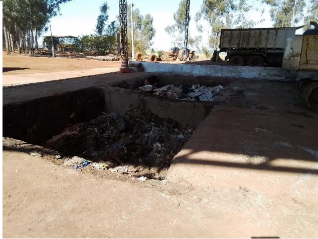
Foto 03: Fossos para blindagem de resíduos
