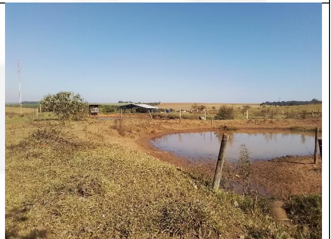
Foto 08: Barramento 1 seguido do tanque escavado
