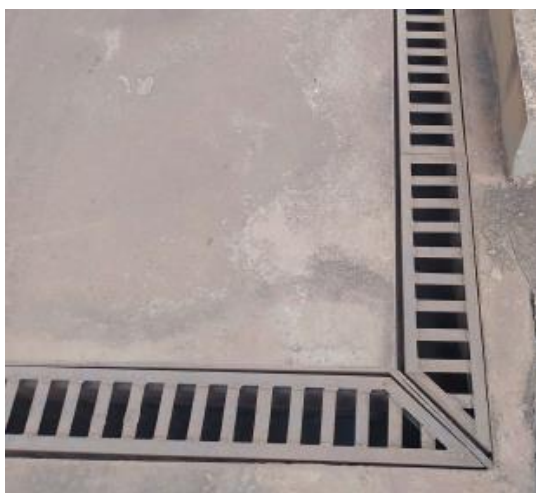
Foto 2 – Canaletas de Contenção Fonte: RAS, 2021.
