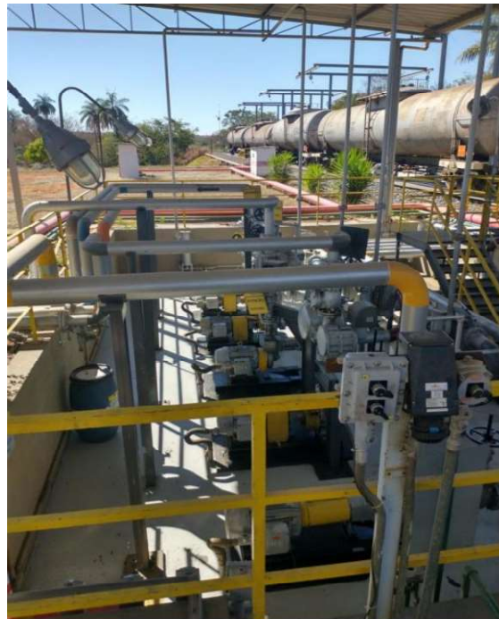
Foto 12 - Sistema de bombas de descarregamento
