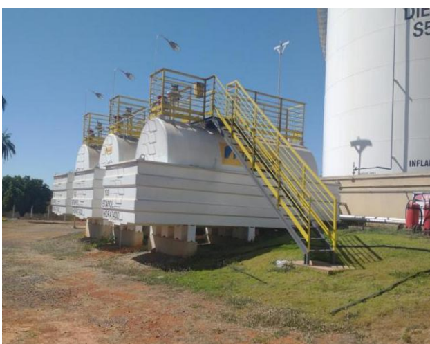
Foto 14 - Visão dos tanques de armazenamento. Foto 15 - Bacia de contenção e seus sub-diques.
