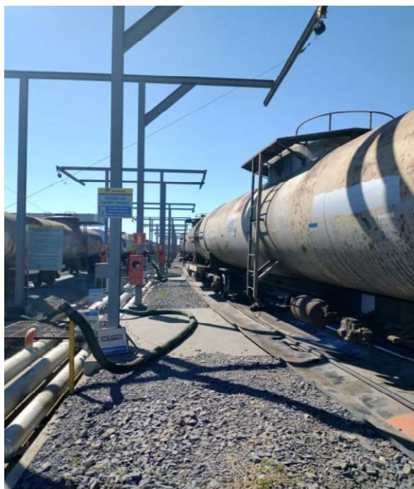
Foto 11 - Descarregamento de vagões tanque
