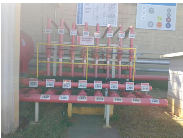
Foto 16 - Sistema de combate a incêndio.
