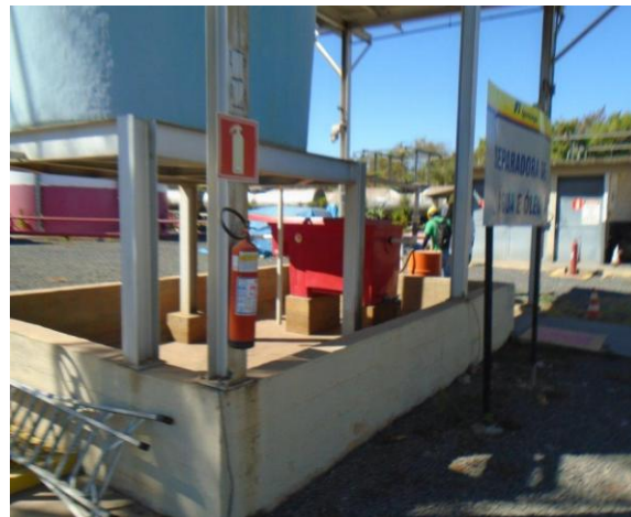
Foto 10 - Caixa separadora de água e óleo.
