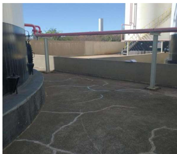
Foto 14 - Visão dos tanques de armazenamento. Foto 15 - Bacia de contenção e seus sub-diques.
