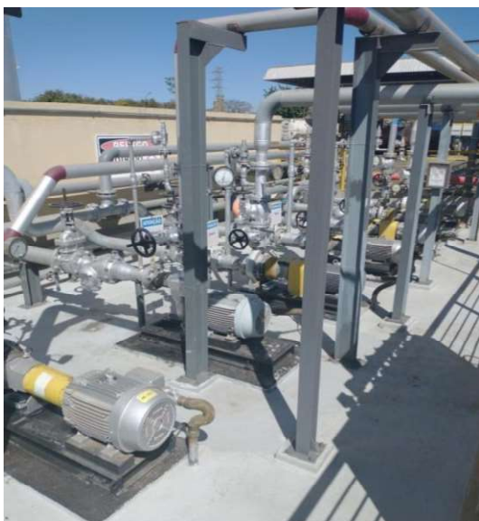
Foto 12 - Sistema de bombas de carregamento. Foto 13 - Visão dos tanques de armazenamento.
