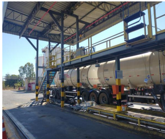
Foto 06 - Plataforma de descarregamento de caminhões tanque.
