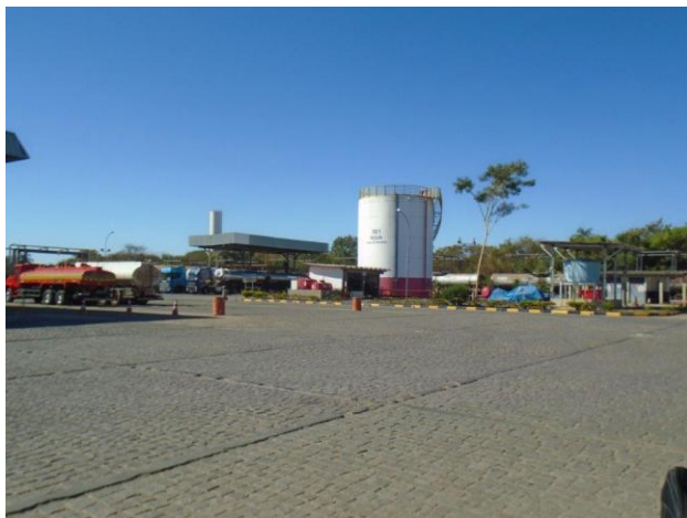
Foto 09 - Tanque de armazenamento de água para combate a incêndio.
