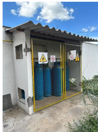
Foto 8: Depósito externo de GLP
