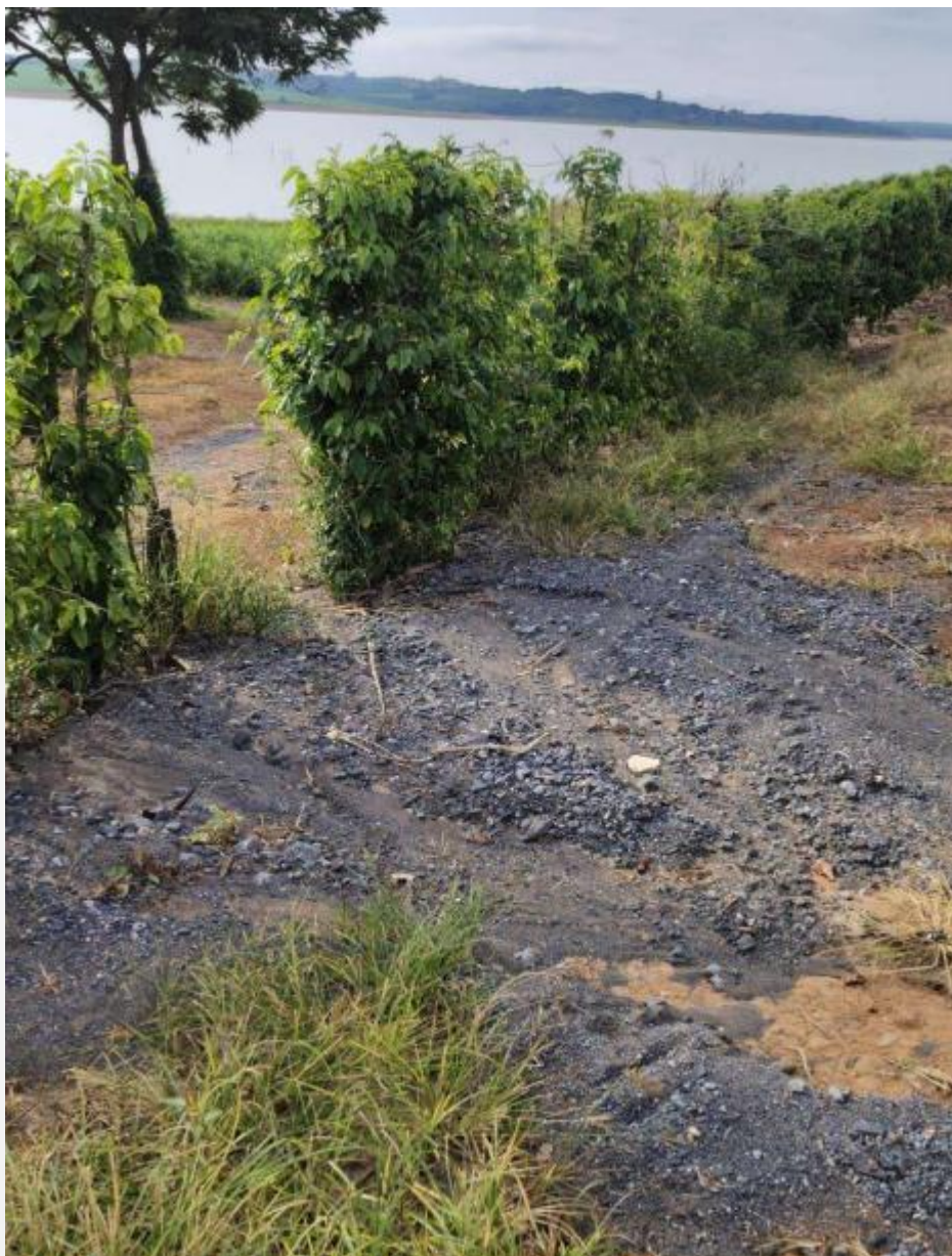
Figura 5 - Carreamento de britas utilizadas para cascalhamento da via
