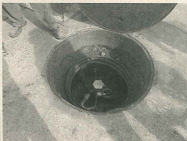
Foto 02. Câmara de acesso às bocas de visita
