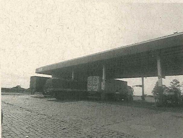
Foto 01. Vista da pista de abastecimento
