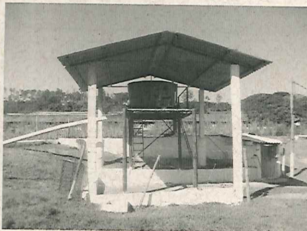
Imagem 3 Separador de sólidos do sistema de tratamento de efluentes
