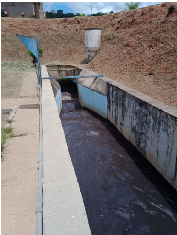
Foto 01: Medidor de vazão, calha Parshall.
