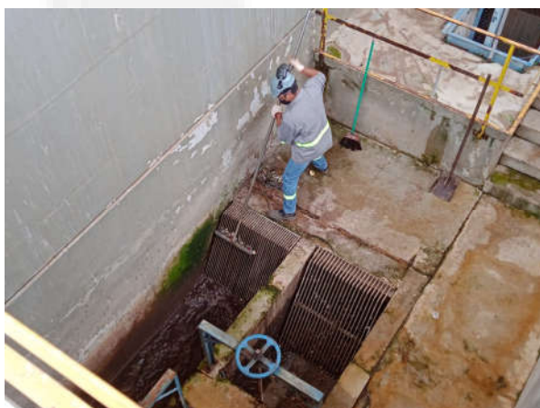
Foto 03: Sistema de gradeamento passando por limpeza.
