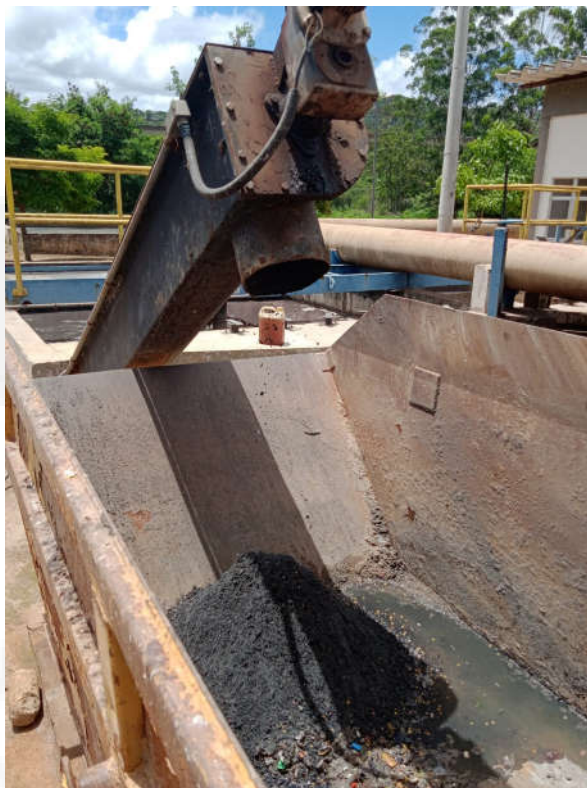
Foto 02: Areia sendo removida do desarenador e direcionada para caçamba.
