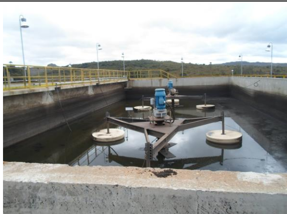
Foto 05. Reator aeróbio
