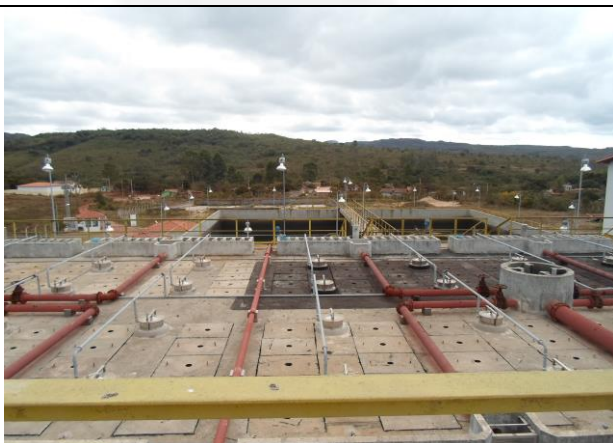
Foto 03. Reator anaeróbio
