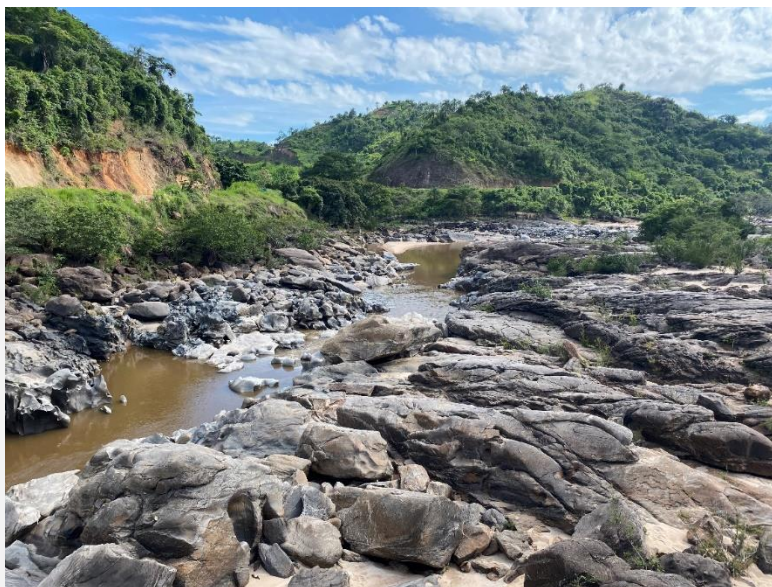
Figura 3: Trecho de Vazão Reduzida da UHE Salto Grande. Fonte: SUPPRI, 2020.
