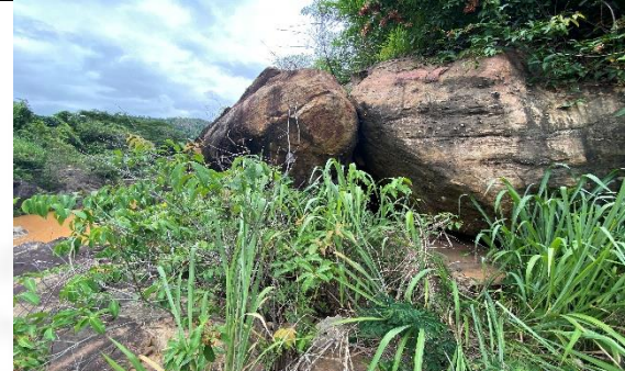
Figura 4 –cavidade às margens do TVR
