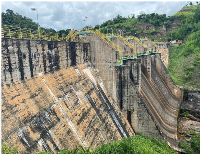
Figura 5: Barragem Guanhães. Fonte: SUPPRI, 2020
