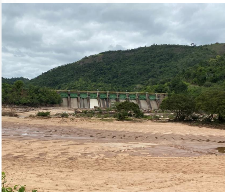
Figura 4: Barragem Santo Antônio. Fonte: SUPPRI, 2020
