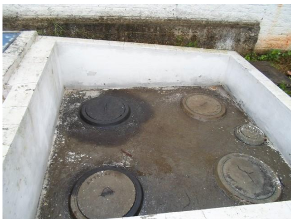
Foto 5- Caixa separadora de água e óleo.
