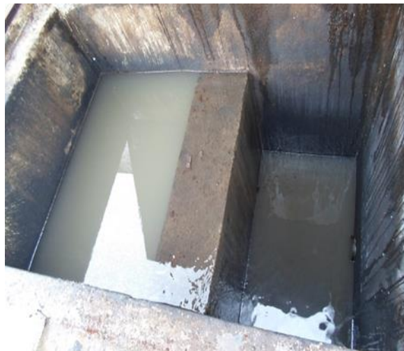
Foto 4- Caixa separadora de água e óleo.
