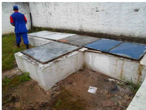
Foto 6- Caixa separadora de água e óleo.
