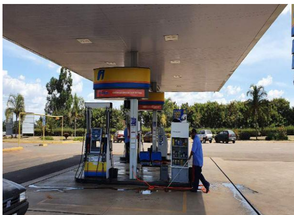
Pista de abastecimento coberta e com canaletas de contenção.
