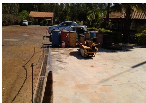
Figura 03. Piso impermeabilizado da oficina
