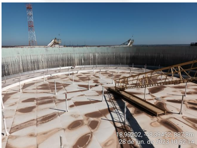
Figura 3: Sistema de teto flutuante do tanque de armazenamento.
