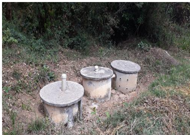
Foto 04: Sistema fossa-filtro-sumidouro.
