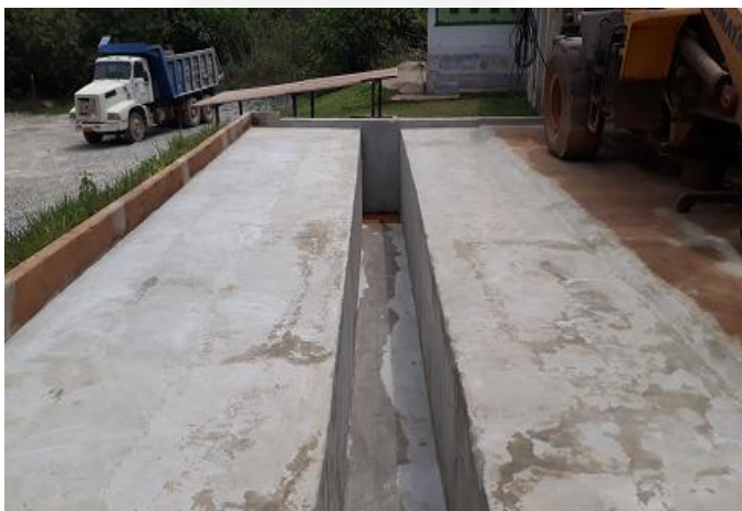
Foto 03: Lavador de veículos dotado de caixa SAO.
