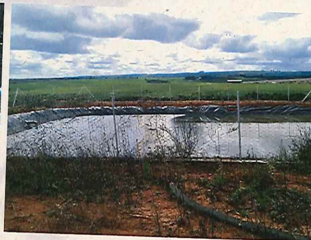
Figura 12. Lagoa de estabilização
