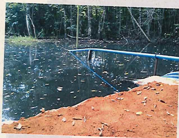
Figura 11. Captação em curso d'água
