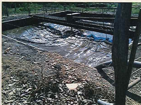
Figura 4. Tanque de retenção das águas residuárias da área de ordenha
