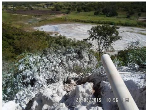
Foto 08: Ponto descarte da lama abrasiva
