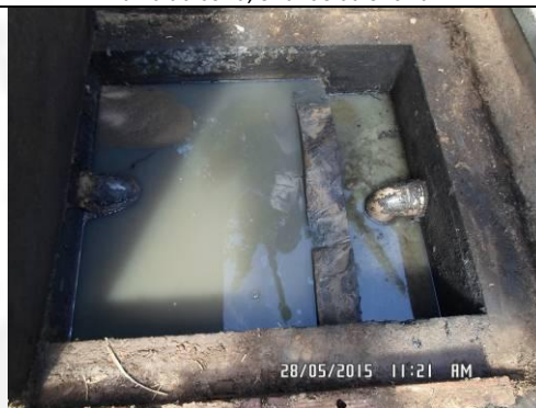
Foto 19: Caixa separadora de água e óleo da oficina
