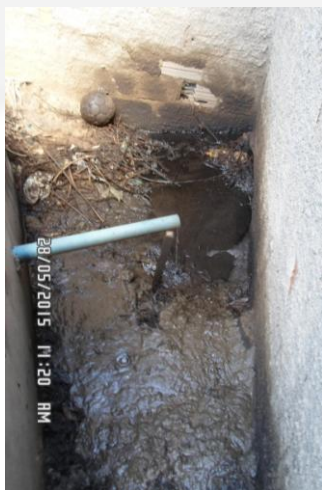
Foto 20: Caixa separadora de água e óleo da oficina
