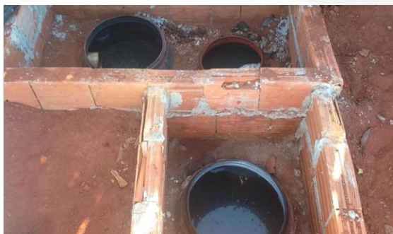
Figura 05: Caixa separadora de água e óleo
