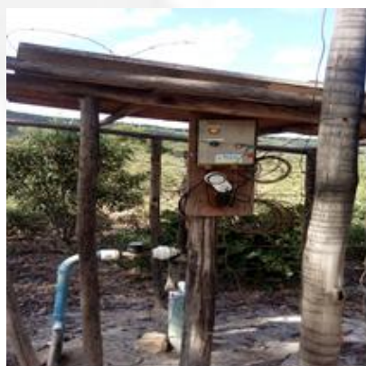
Figura 11: Captação em poço tubular, horímetro e hidrômetro instalados.
