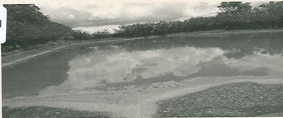
Figura 03 – Lagoa de tratamento de efluentes sanitários
