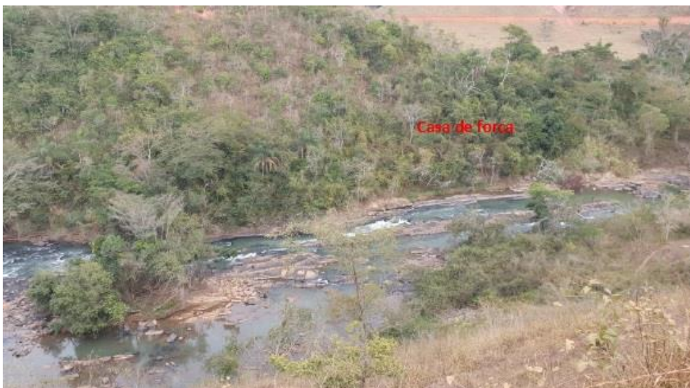
Figura 2: Casa de Força
